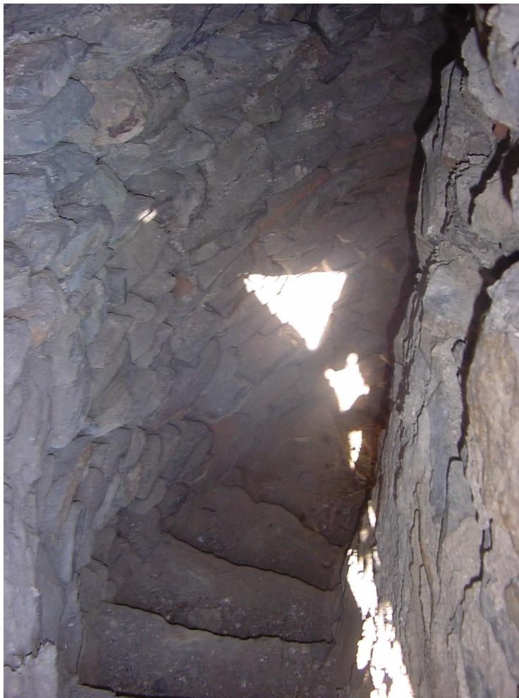
Escalera de caracol de la Torre Vigía. Reporte fotográfico del Ayuntamiento de Torrenueva Costa con fecha de octubre de 2025.
