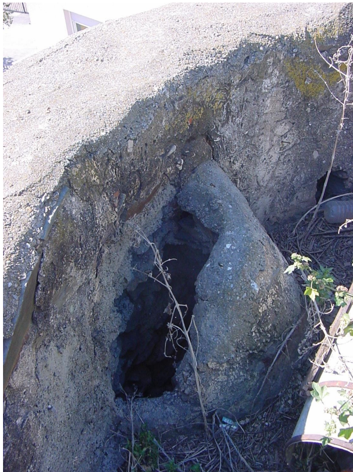
Salida de chimenea en la terraza de la Torre Vigía. Reporte fotográfico por parte del personal de mantenimiento del Ayuntamiento de Torrenueva Costa con fecha de octubre de 2025.
