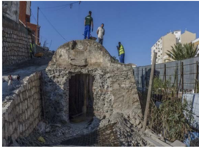
Aljibe antes de ser restaurado. Archivo fotográfico del Ayuntamiento de Torrenueva Costa.
